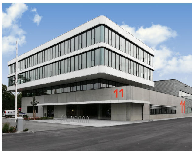
Radiopharmazeutische Fertigung, Umbau, ITM, Neufahrn bei Freising
