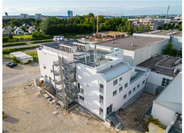
Die Richter Pharma AG betreibt in Wels (Österreich) für das Tochterunternehmen VetViva Richter GmbH eine Abfüllanlage für sterile veterinärmedizinische Lösungen. Aufgrund des fortgeschrittenen Alters der bestehenden Anlage wurde der Bau einer neuen Abfüllanlage einschließlich Reinräume und Versorgungssysteme notwendig, mit dem Ziel, den Output zu verdreifachen. Zu diesem Zweck wurde auf dem Parkplatz der bestehenden Anlage ein zweistöckiges Gebäude mit Keller errichtet.
