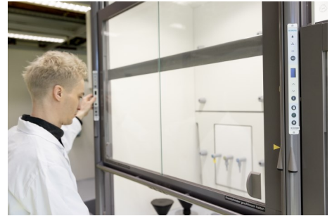
Nutzer werden am Bediengerät des Abzugs darauf hingewiesen, wenn ein unsicherer Zustand eintritt oder der Luftverbrauch unnötig hoch ist.
