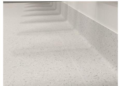
*Dank der dauerhaft UV-vernetzten Oberflächenvergütung und der Ausbildung von Hohlkehlen verfügt der Belag über eine exzellente Reinigungsfähigkeit sowie eine sehr hohe Beständigkeit gegenüber mechanischen Belastungen und chemischen Angriffen.*
