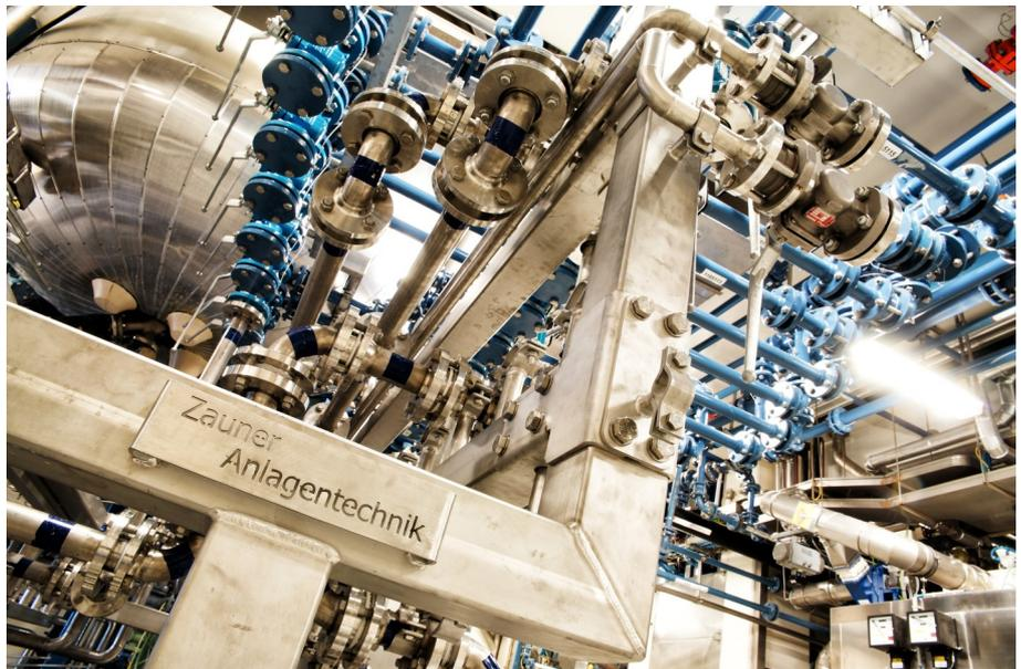
einer Fehlerrate von weniger als 0,5% hergestellt. Die Druckprüfung, Reinigung & Passivierung; Isolierung und Dokumentation der Rohrleitungssysteme zählte ebenfalls zum Lieferumfang der Zaunergroup.
