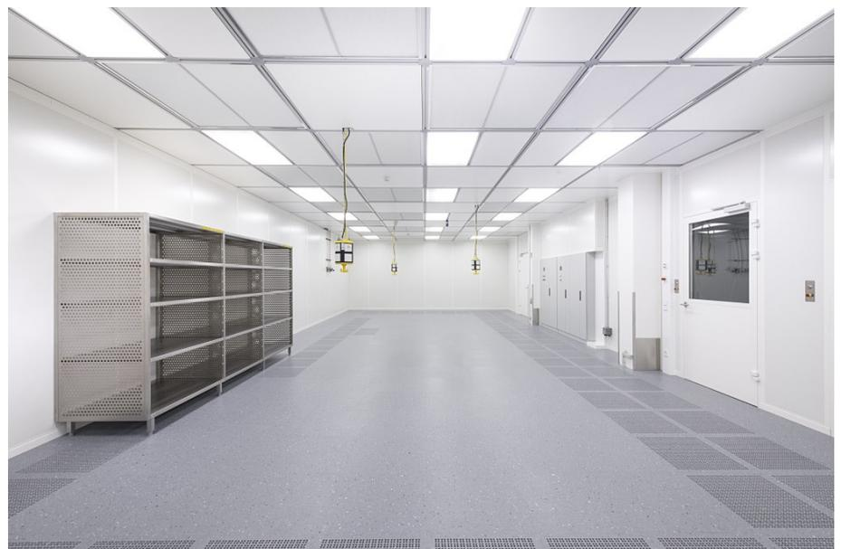
Hervorzuheben ist ein freistehender Reinraum, in dem Boden-Decke-Wand als Verbund in das Belüftungskonzept integriert wurde.
